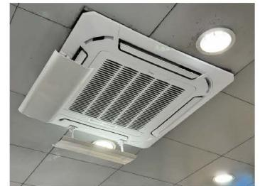
本院本年度參加機電工程署的綠色社福機構：社福機構處所能源審核和能源改善工程支援計劃，將全院的冷氣機更換為變頻式冷氣機，有冷暖氣提供之餘，亦更能響應環保，節省10–15%電量。
